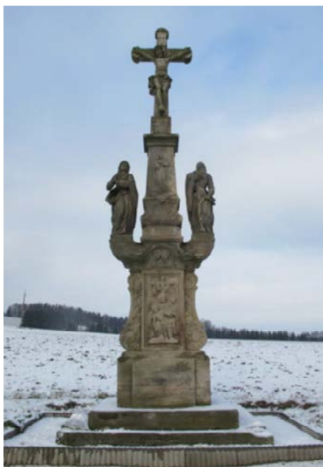
Stav před zahájením restaurátorských prací
