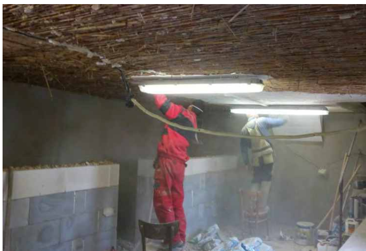
Odstranění stávajícího stropu prodloužilo rekonstrukci
