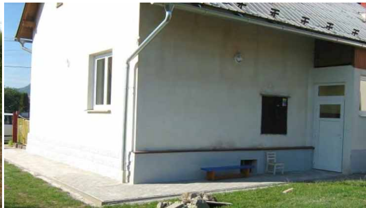
Na budově byla opravena podezdívka, byl vybudován nový chodník ze zámkové dlažby a byly vyměněny okapy a svody, aby nám již na školku neteklo
