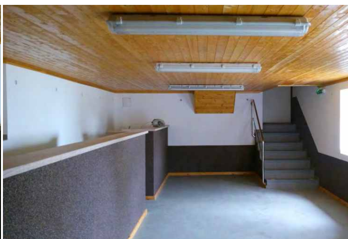
Barový pult pokrývá pracovní deska, schody jsou obloženy dlažbou, nová zábradlí jsou nedílnou součástí nové chlouby našeho kulturního domu
