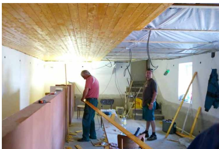
Nový odvětrávaný strop z palubek
