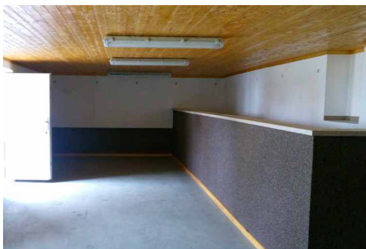
Z bezpečnostních důvodů bylo jedno okno nahrazeno plastovými dveřmi, které budou sloužit jako únikový východ, který je z venku chráněn přístřeškem
