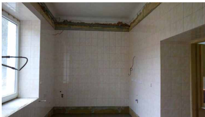
Všechny zdi musely být vyrovnány a nově obloženy, pod stropem byla zhotovena nová vzduchotechnika k nové varné technice pro zdravé vaření
