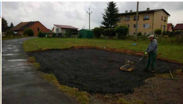
Příprava sběrného místa k umístění kontejnerů
