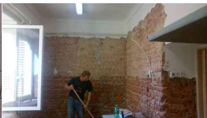
Bylo nutné zcela odstranit původní omítky a obklady
