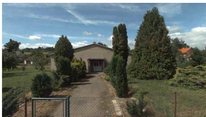
Prostor u Klubu důchodců před rekonstrukcí
