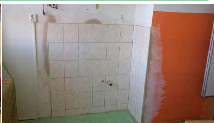
Prostor po obložení obklady a spárováním. Celkem byly opraveny dvě třídy
