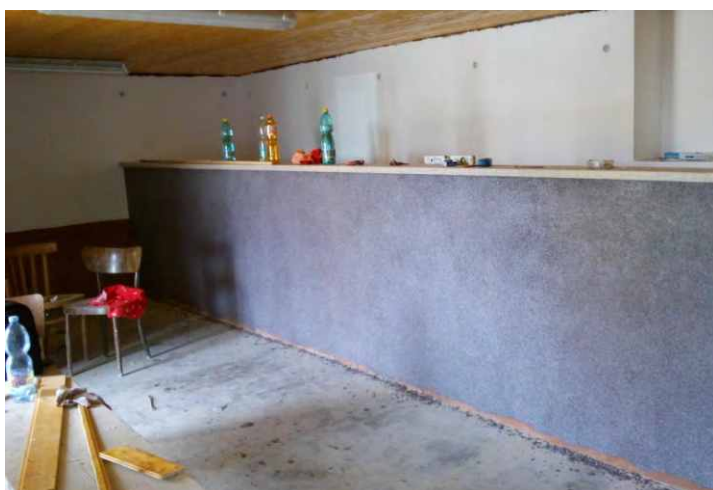
Nový barový pult s povrchovou úpravou z marmolitu
